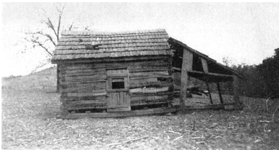
Dřevěný srub nedaleko městečka Burkesville, Kentucky, kde se 6. Dubna 1909 narodil kazatel William Branham
